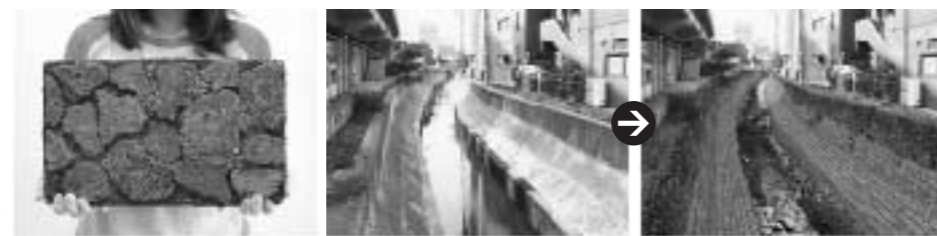
↑NPO法人渋谷川メンテナンスは、このパネル(日本ナチュロック社製)を渋谷川のコンクリート護岸へ恒久設置するプロジェクトを進めている。
